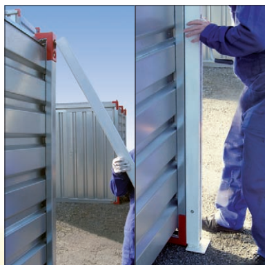
1 - Encliquetage des béquilles.
